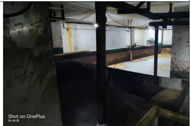
污水预处理站位于下沉式地下室，各池体为接地池体
