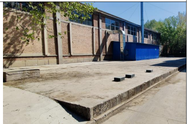
污水预处理站位于下沉式地下室，各池体为接地池体
