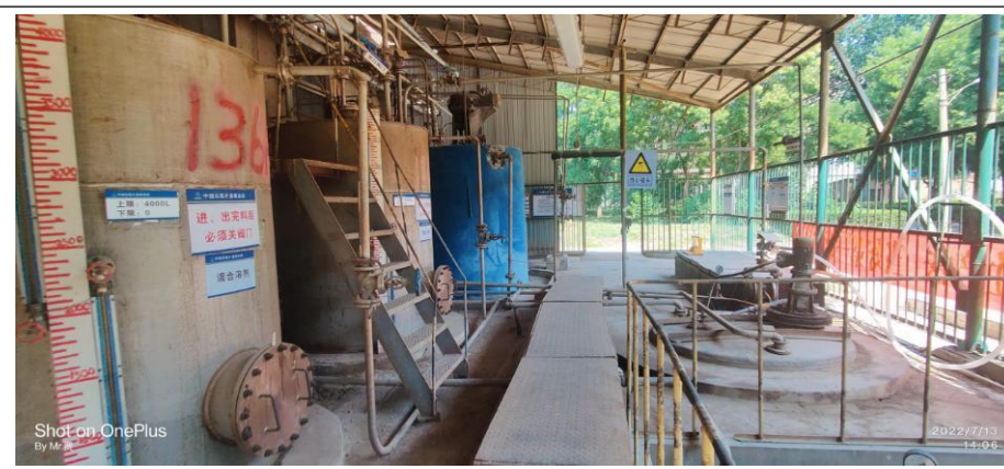
一部片基回收：混合溶剂罐（4个，接地），污水罐（1个，地下3.0,m）
