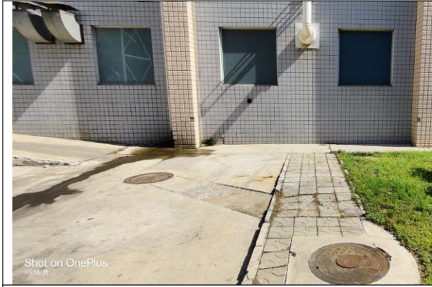
涂布车间（6号机）1楼刷桶区废水外排管线
