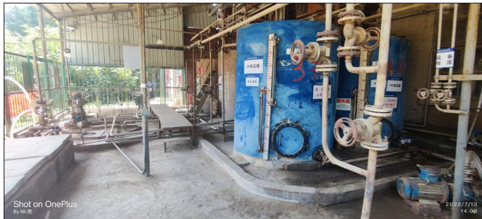
一部片基回收：混合溶剂罐（4个，接地），污水罐（1个，地下3.0,m）
